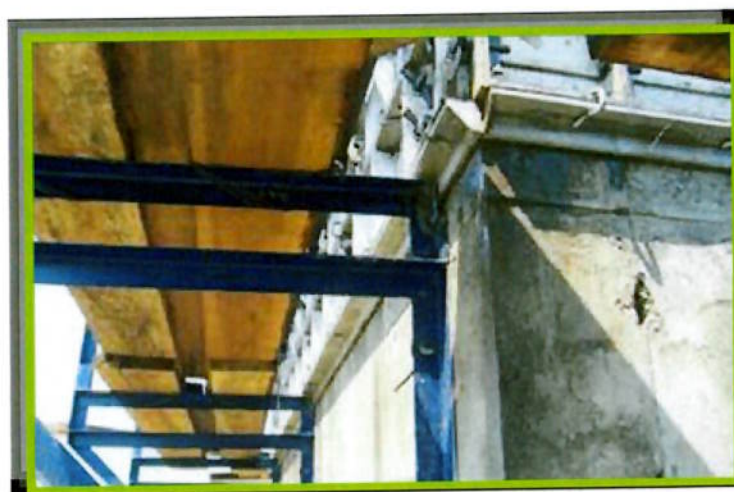
Figura 21 – Colocação do Assoalho da Plataforma de Trabalho (fonte: catálogo técnico FORSA)
