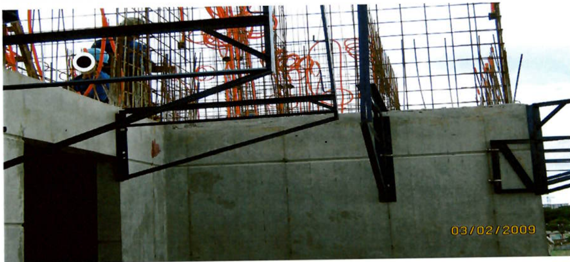
Figura 24 – Fixação dos suporte na parede concretada (fonte: o autor)
