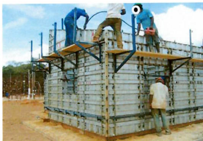
Figura10 – Durante a Concretagem (fonte: catálogo técnico FORSA)
